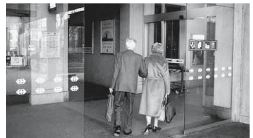
Bild 2: Bei Türen aus durchsichtigem Material sind wenn nötig Markierungen anzubringen.
